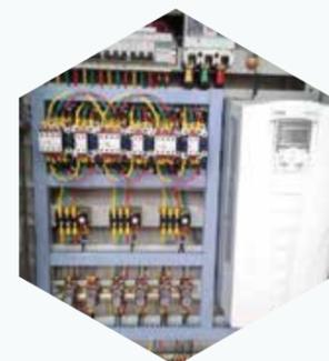
ПЛК + один частотный преобразователь
